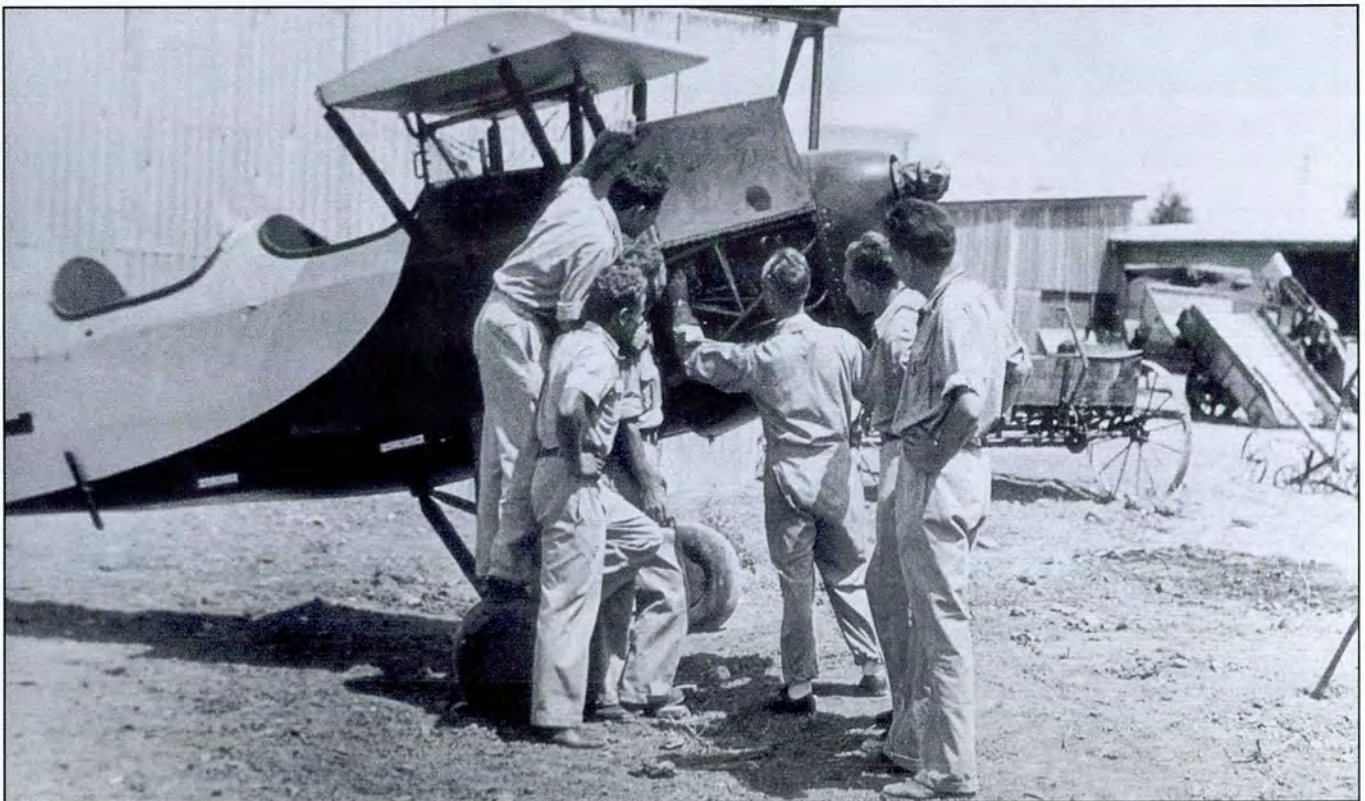
למעלה: כך מתניעים: חניך אחד מסובב את המדחף, והשני לוחץ על מתג ההתנעה. למטה: שיעור בתורת המנוע. סמוך לרפת, מסביר לחבריו החניך פוהויליה, מהנדס בהכשרתו, על מנוע ה"גייפסי" של מטוס ה-RWD-8
