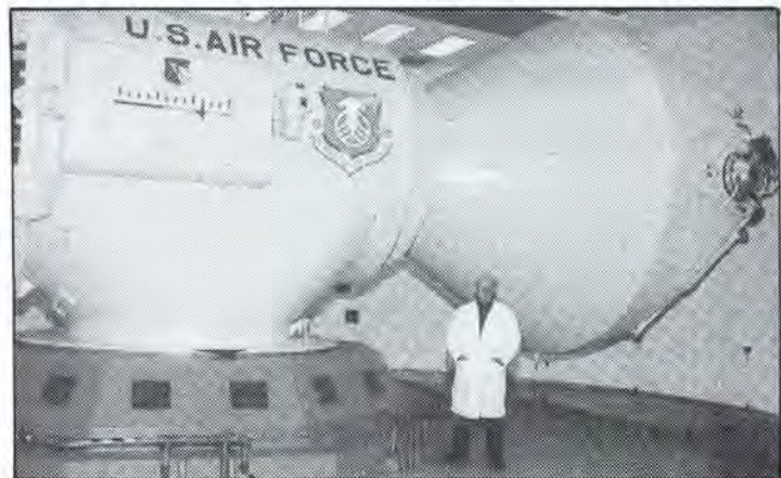
מתקן הצנטריפוגה של חיל-האוויר האמריקני שבו אפשר ולגרום למצבי גי' ולבחון את השפעותיהם
