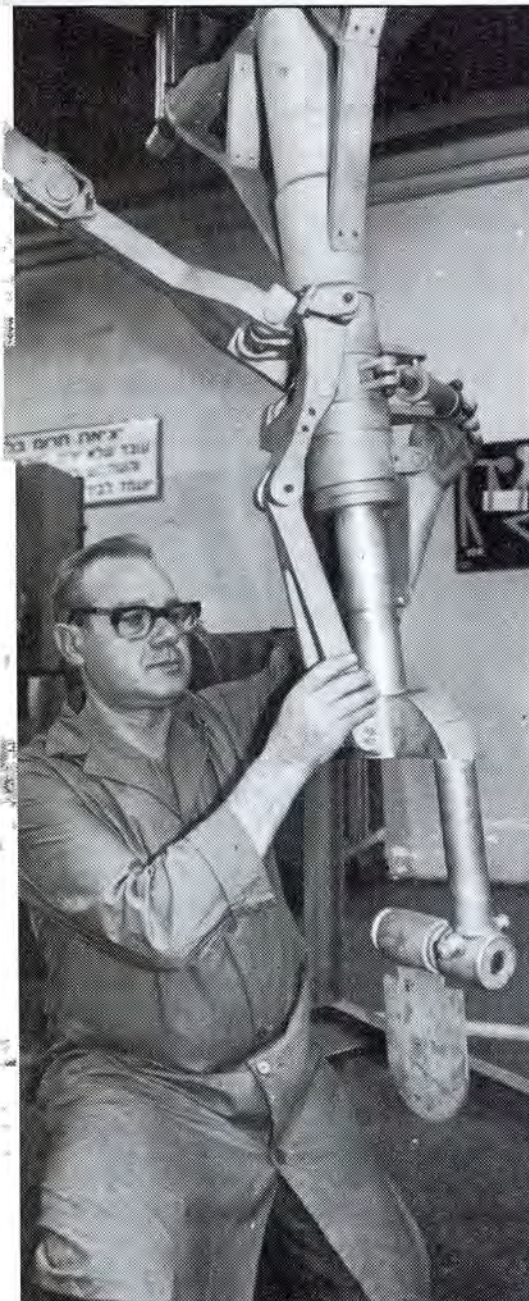
אחד מכני הנסע האחוריים של הלבאי נבדק בקפידה לפני שיורכב על מתקן הניסוי שיבדוק את חוזקו ואמינותו
